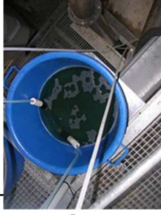
Bac de solution et crépines de pompage
